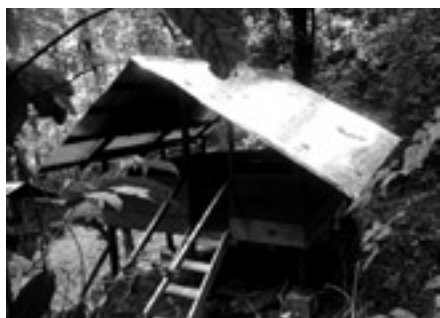
En haut: le nouveau dortoir du camp de base d'Afi; en bas: la salle commune rénovée du camp de base d'Afi
