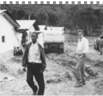
Carlos Schuler vor neuen Wildhüter-Unterkünften, deren Bau von der Born Free Foundation finanziert wurde.
