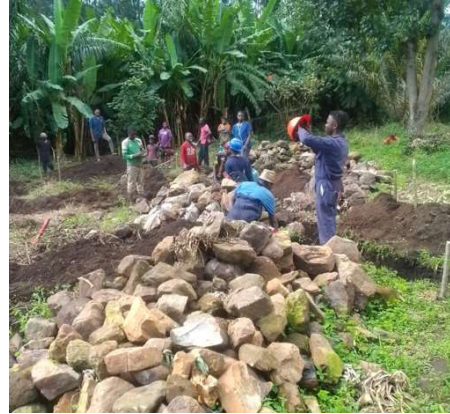
Institut Nyarubungu: Jeder Bau beginnt mit Fundamentarbeiten
