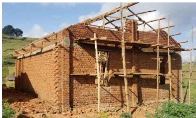
Der neue Klassenraum in Kisanga am Mount Tshiaberimu während der Bauarbeiten © Kasereka Gervais
